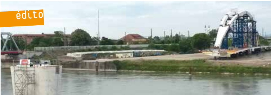
Le nouveau pont tram vers Kehl franchira bientôt le Rhin.
